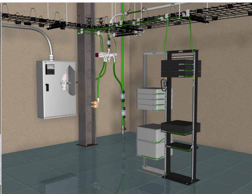
Cuarto de Telecomunicaciones
