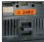
Kennzeichnung elektrischer Gefahren
