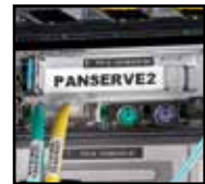
Beschriftung von Netzwerkinfrastrukturkomponenten
