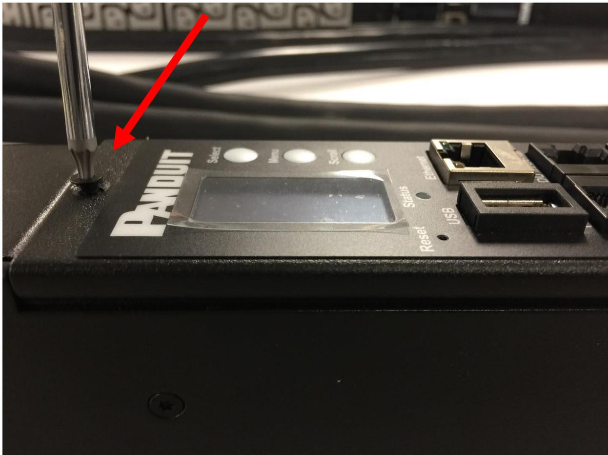
**Figura 91: Remover los tornillos superiores e inferiores del controlador de red inteligente**
